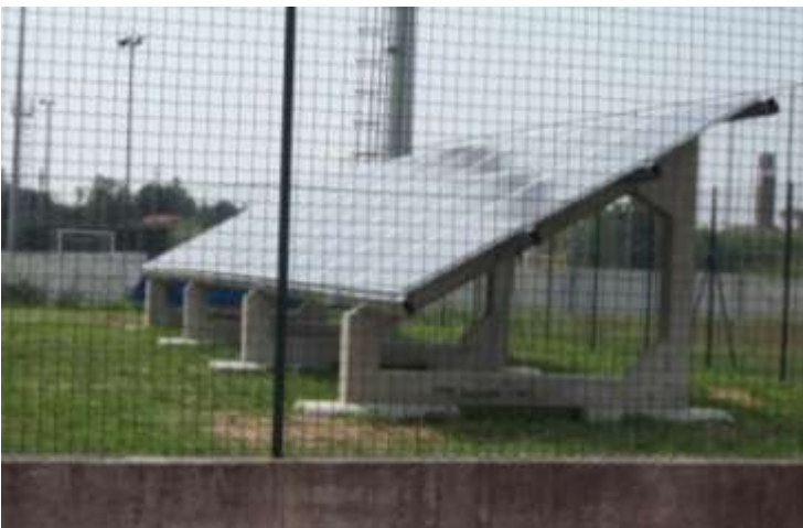
Zavorre in cemento per impianto fotovoltaico presso centro sportivo.
